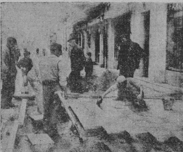
Así están pavimentando una de las manzanas de la calle Rica. Las masas graníticas están sustituyendo al viejo y estropeado suelo de la calle más central de la ciudad. Y la obra se realiza con la rapidez y eficiencia que el caso requiere. Premio para nuestro Ayuntamiento. — (Foto ARJO)
