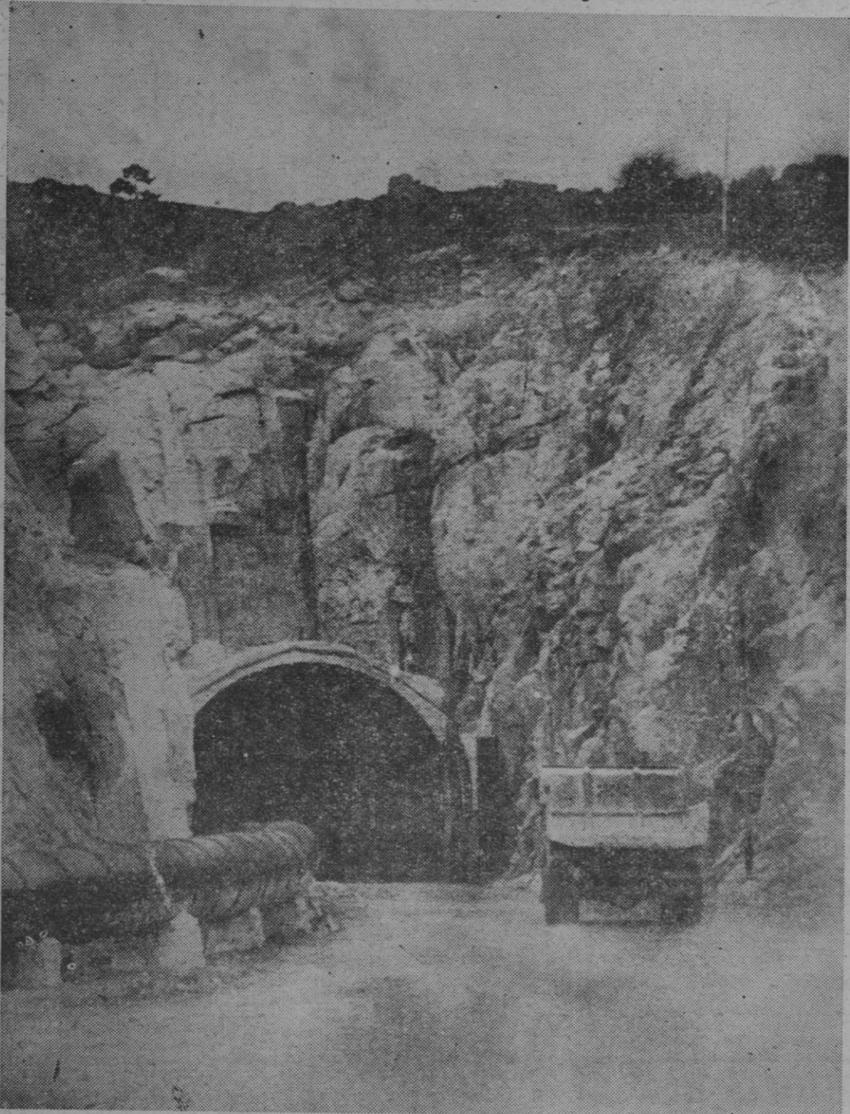
Por ambas bocas del túnel de Guadarrama ya circulan camiones. En la del norte llegan hasta los trescientos sesenta metros y, en la del sur —a la que corresponde la fotografía— hasta rebasar los doscientos cincuenta. Son los de la empresa constructora, empleados en el transporte de la gran cantidad de piedra que los barrenos arrancan de las entrañas de la tierra. (Foto EUROPA PRESS)
