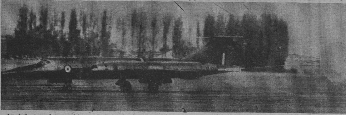
Ayudado por el paracaídas de contención, el "Bristol 188" en el justo momento de tomar tierra después de su vuelo de prueba. El nuevo modelo está equipado con dos turbo-reactores y su destino es realizar experiencias sobre la barrera del calor. En su primer vuelo, el aparato fue pilotado por Godfrey Auty, de cuarenta y dos años de edad. La reciente prueba se efectuó con completo éxito entre Filton Bristol y Boscombe Down.
