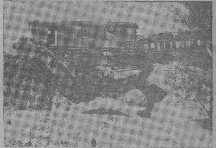
CALATAYUD.—Estado en que quedaron algunos de los vagones del tren de viajeros que hacía el servicio entre Soria y Calatayud al desplomarse un puente. (Foto CIFFRA).
