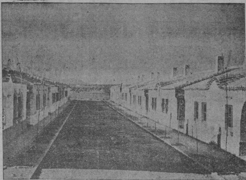
JAEN.—Una de las calles del nuevo grupo de 49 viviendas protegidas, con su correspondiente grupo escolar, que ha construido Regiones Devastadas en Martos (Jaén)
