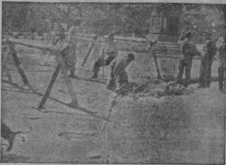
Como hemos informado en nuestro número de ayer, se dieron comienzo las obras de nueva pavimentación en los Cantones. Nuestro fotógrafo ha captado el momento en que unos obreros proceden a levantar la capa asfáltica que actualmente cubre las principales avenidas coruñesas.
