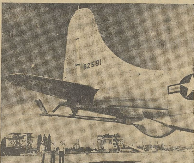
El abastecimiento de combustible a los aviones en pleno vuelo, ya no reviste dificultades ni peligros. En la foto puede apreciarse el tubo que emerge de la cola del "Boeing" y por la que circula la gasolina, que, en pleno vuelo, se puede repostar a otro avión.
