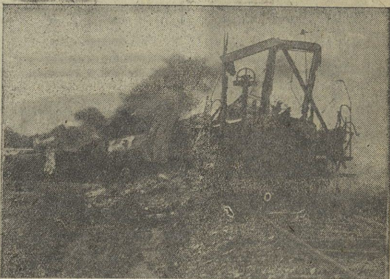
Así quedaron la locomotora y las oisternas, ampatadas y volcadas al lado de la vía
