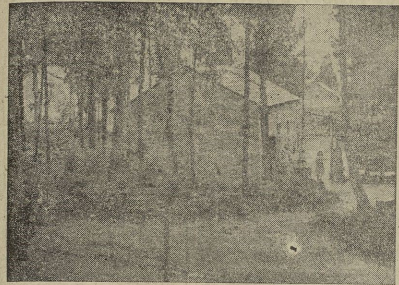
Los pabellones en los que estaban instalados los servicios de secado, amasado y empaquetado
