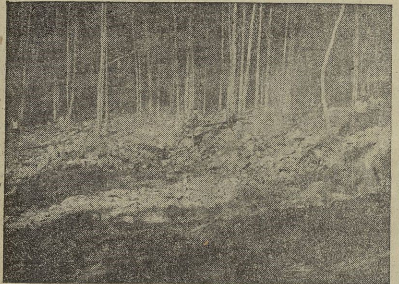
Esto es lo que quedó de los pabellones después de la explosión.
