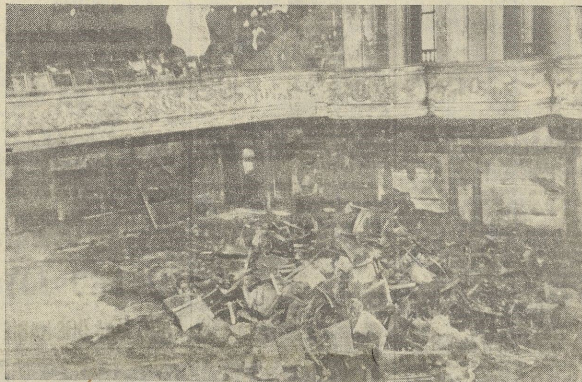
Esto fué el patio de butacas del Teatro Colón. Sobre el piso de cemento —el maderamen del suelo también quedó carbonizado— se amontonan los restos calcinados de las butacas, ya si todas lanzadas ya del piso superior, también grandemente afectado. Los palcos del lado impar sufrieron también los efectos de las llamas. El aspecto, como se ve, es desolador
