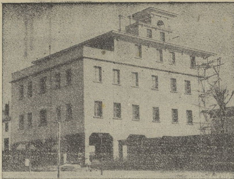
Edificio en construcción para el Ayuntamiento de Ordenes
