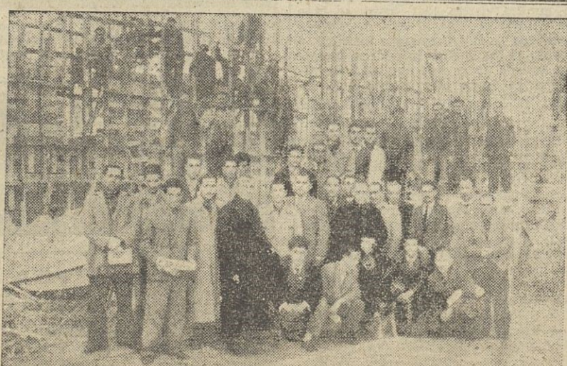
La última Tanda de Ejercicios Espirituales, con 25 empleados y oficinistas de La Coruña, dirigidos por el R. P. Rubinos, visitando las obras de la magnífica Casa de Ejercicios que los católicos coruñeses están construyendo en las alturas de Bastiagueiro
