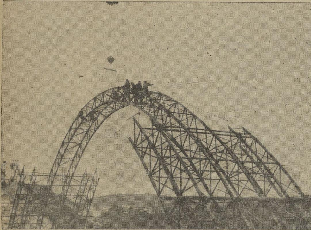
Armazón del arco central del viaducto sobre el río Ulla, en el trayecto ferroviario Santiago-Orense (Foto Ksado)
