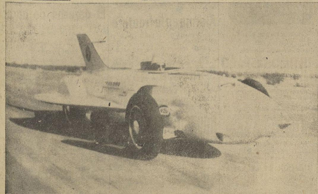
El automóvil de la General Motors XP-21 durante las pruebas en Arizona. Este es el primer automóvil con motor de turbina
