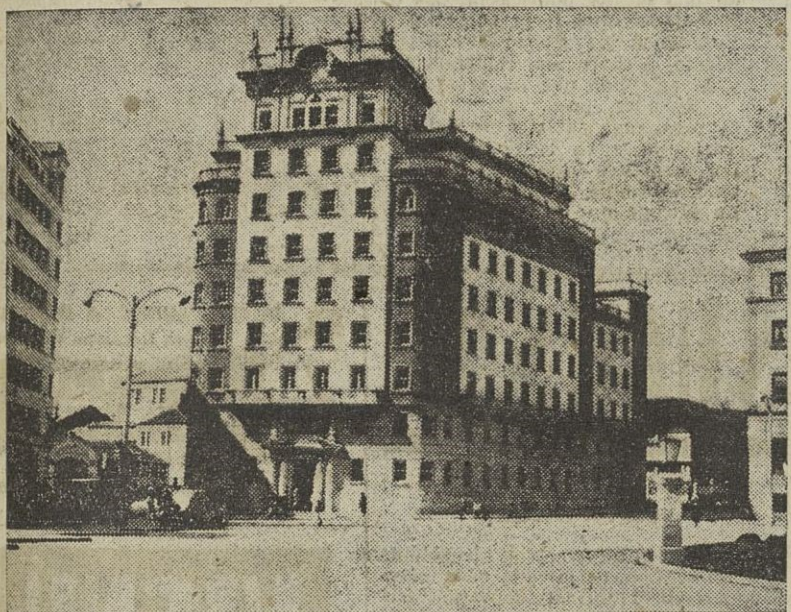
Un aspecto de las 56 viviendas para jefes y oficiales del Ejército, entregadas por el Capitán General de la Región y realizadas por el Servicio Militar de Construcciones. Estos bloques de viviendas se levantan en la Plaza de España de El Ferrol del Caudillo
