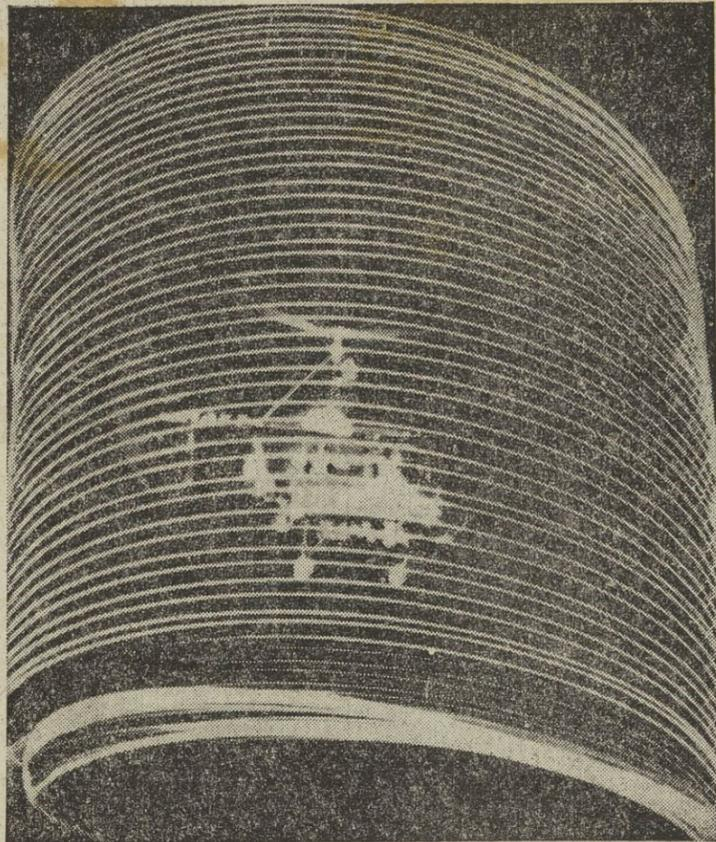
He aquí un helicóptero de la Marina de los Estados Unidos "preso" en las espirales que iluminan las ráfagas de sus faros, adosados a las aspas. El nuevo sistema de iluminación permite los aterrizajes nocturnos con el motor en marcha y una velocidad de 240 revoluciones por minuto (Foto A. P.)
