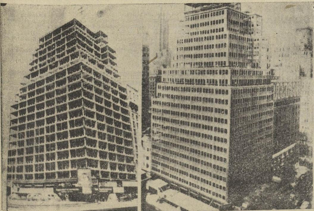
Estas dos fotos muestran un edificio de 22 pisos en Nueva York, antes y después de haber efectuado en él una jornada de 9 horas y media, por 61 operarios, al ser recubierto con planchas de aluminio, ya prefabricadas, y que hubieran tardado, los mismos operarios, diez semanas con los procedimientos normales de construcción.
