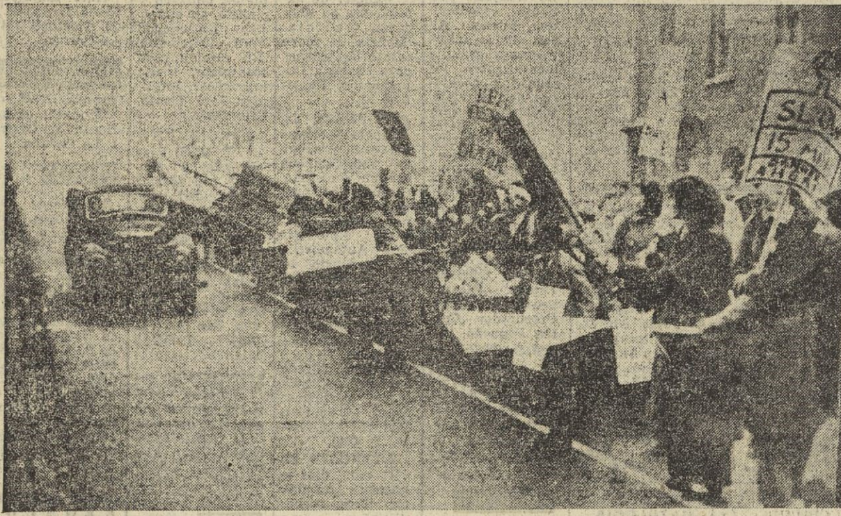
Los habitantes de Marlyate, cerca de Londres, piden una desviación para evitar que la carretera nacional pase por el centro del pueblo. Se calcula que en la actualidad 10.000 coches diarios pasan por el centro de dicho pueblo. (Foto A. P.)
