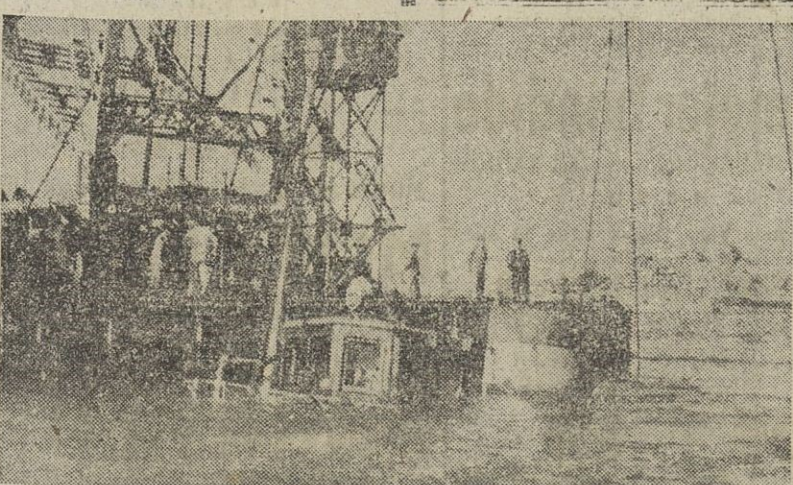
CARTAGENA.—El remolcador "RP-21", naufragado hace un mes frente a Cartagena, ha sido puesto a flote por la grúa flotante "Sansón", de la Marina de guerra y conducido a flor de agua hasta el Arsenal.
