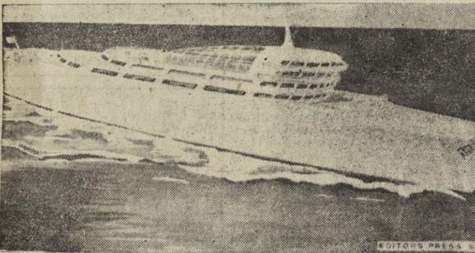
Ilustración núm. 2. El trasatlántico atómico puede llegar pronto. El reactor, sin chimeneas produce el vapor que mueve las turbinas y las hélices.
