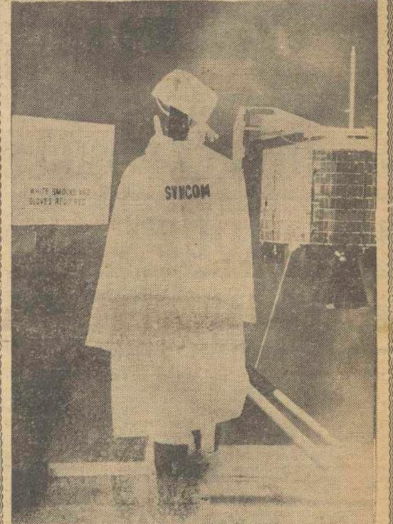
CABO CAVERAL. ... Fotografía antes de su lanzamiento en Cabo Cañaverl del satélite de comunicaciones "Symcon" que, operado en una órbita de 39.000 kilómetros y con movimiento sincronizado con la Tierra facilitará las comunicaciones mundiales las 24 horas del día. En la foto, el satélite "Symcon" junto a la bata, gorro y guantes requeridos para todos los que trabajan en el proyecto. -- (Foto E. Press).
