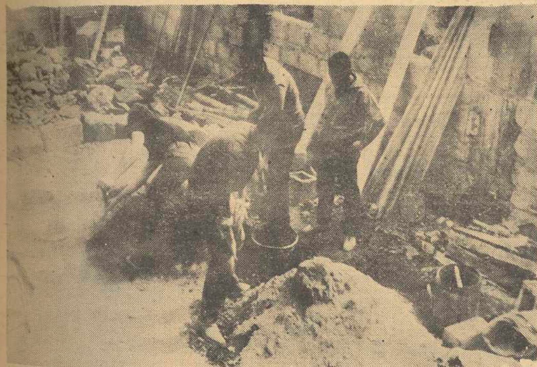
Cuatro estudiantes componiendo la mezcla que dará fortaleza a los cimientos de las casas de los trabajadores. — (Foto: E. P.)
