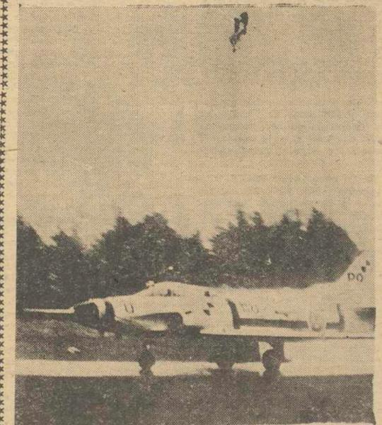
ESTOCOLMO. — La industria sueca ha lanzado al mercado este nuevo asiento para piloto, que en casos de emergencia es lanzado 60 metros por encima del avión. Cuando piloto y asiento encuentran en el aire automáticamente se abren dos paracaídas: uno para cada uno, que permiten el descenso a tierra con suavidad. En la foto, una de las pruebas de asiento catapultado. — (Foto Europa Press)
