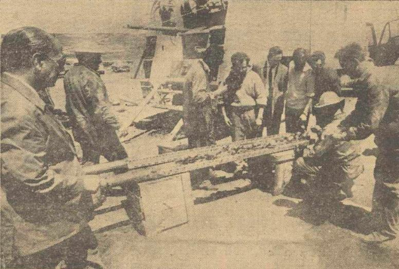
SARGENTES DE LORA, (Burgos).— Con el fondo del laboratorio móvil, aparece en la fotografía un momento del montaje de la sonda eléctrica "side wall core", con la que ha quedado testificada la riqueza petrolífera del yacimiento "Ayoluengo 1". (Foto EUROPA PRESS)
