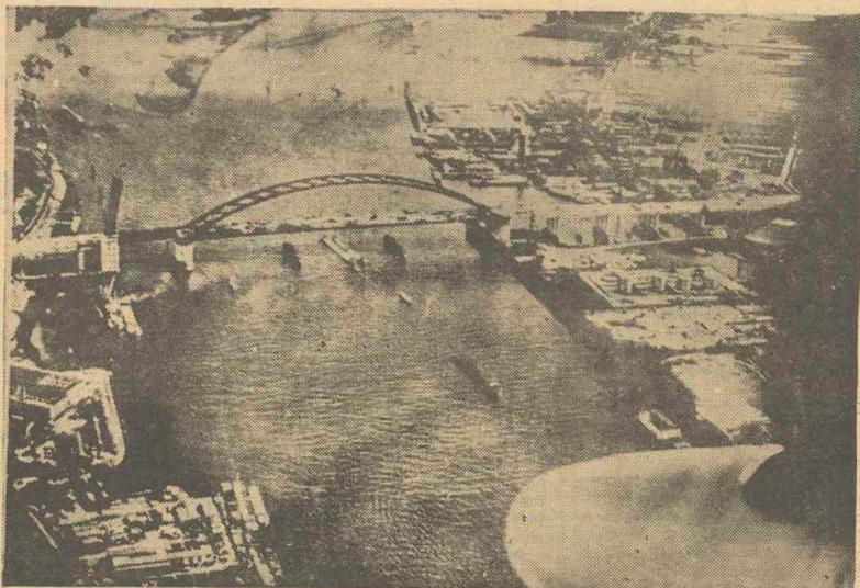
Vista aérea del nuevo puente, de Pienencortdece sobre el río Maas, en Rotterdam, Holanda. Sobre dicho puente correrá la carretera que va del noroeste de Holanda a las provincias del Sur y a Bélgica. El arco principal tiene 850 pies de largo y está suspendido de una estructura de acero de 150 pies. A la izq. del puente se abrirá un sector del mismo para que puedan pasar los barcos de mayor calado.— (Foto AP-LÓGOS).
