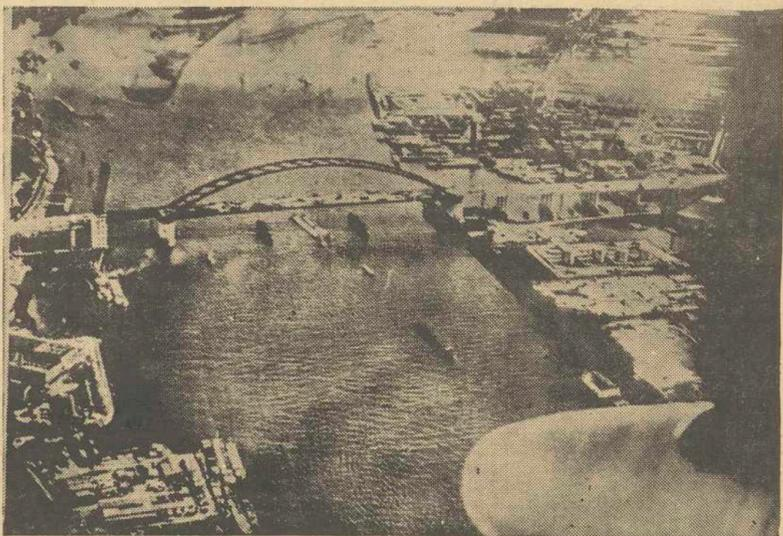
Vista aérea del nuevo puente, de Pienencorides sobre el río Maas, en Rotterdam, Holanda. Sobre dicho puente correrá la carretera que va del noroeste de Holanda a las provincias del Sur y a Bélgica. El arco principal tiene 850 pies de largo y está suspendido de una estructura de acero de 150 pies. A la izquierda del puente se abrirá un sector del mismo para que puedan pasar los barcos de mayor calado.— (Foto AP-LOGOS).
