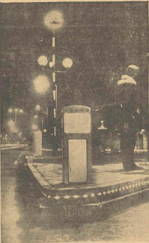
El cruce de carreteras de Clapham Common North y Elspeth Road, al Suroeste de Londres, con el nuevo sistema de iluminación instalado en los bordillos contra la niebla. El invento, llamado "Lumistrip" consta de luces amarillas, que destellan hasta una distancia de unos 500 metros, instaladas en las piezas especiales de cemento montadas en los bordillos de aceras, urbanas y de carretera. — (FOTOFIEL)
