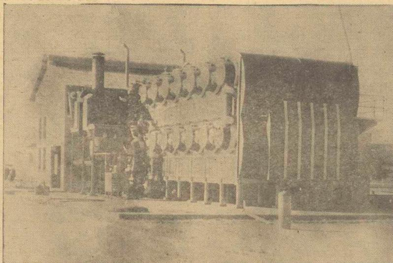
Esta instalación evaporadora británica funciona, en parte, con el calor proporcionado por los gases de escape de un motor diesel de central eléctrica. Está situada en Bonaire (Antillas Holandesas). Algunas de estas centrales evaporadoras producen hasta 50 millones de litros diarios de agua dulce procedente del agua salada.
