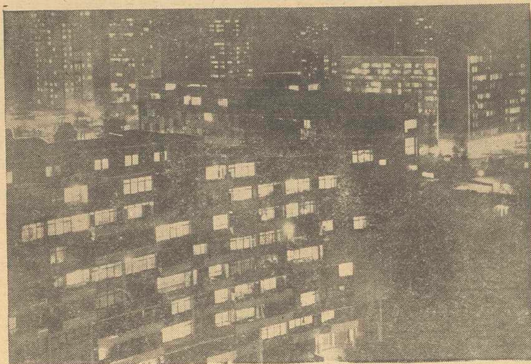
El "Barrio Hansa" de Berlín Occidental durante la noche. ¿Confort en palacios de viviendas?
