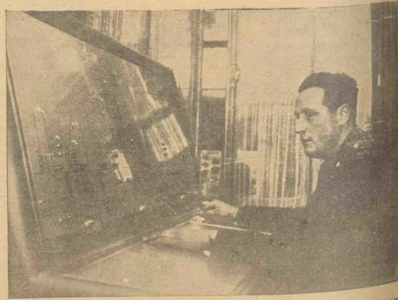
En la central de policía de Neuchâtel, la señalización luminosa del tráfico es comprobada permanentemente desde esta mesa donde se encuentra reproducida la red completa de señales, permitiendo cambiar las bases luminosas según la densidad de la circulación.-- (FOTOFIEL).
