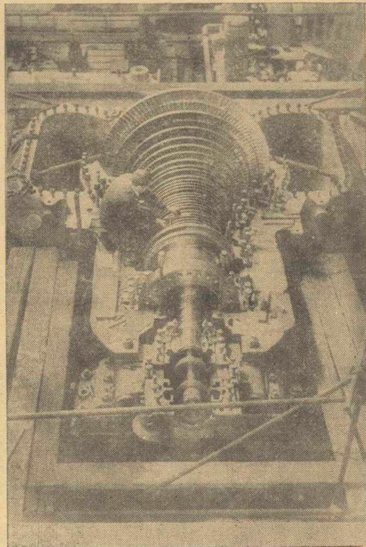
En los talleres de Maquinaria de la factoría de la Empresa Nacional «Bazán» de El Ferrol del Caudillo se acaban de realizar las pruebas de sobrevelocidad de la primera turbina de «vapor terrestre» construida en España, con destino a la Central Térmica de Puente Nuevo (Córdoba).
