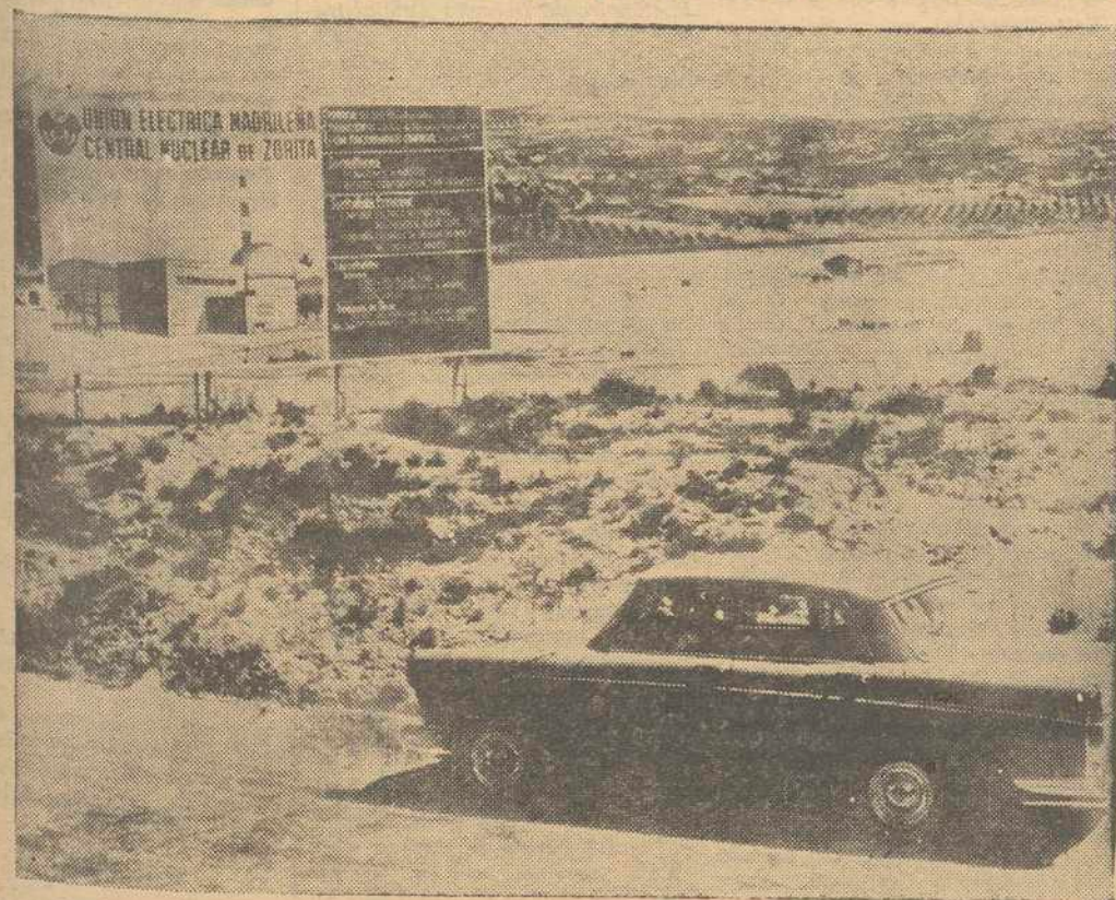
He aquí una vista del emplazamiento de la Central Nuclear de Zorita de los Sinos, Guadalajara, con el anuncio del proyecto de obras en primer término, y al fondo el cauce del río Tago. Con la asistencia del Ministro de Industria ha tenido lugar la bendición e inauguración de esta central nuclear.— (FOTOFIEL)
