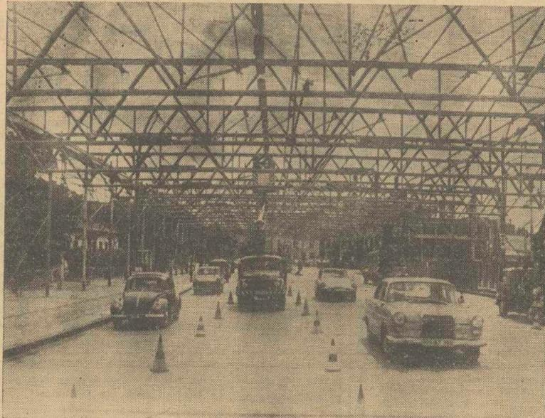
Va a construirse en Hamburgo-Elmsbuetel una gigantesca torre para la televisión, precisamente junto a la calle que vemos en la fotografía. Para proteger a los automovilistas y peatones de la caída de algún objeto se ha montado este techo de tubos metálicos y red protectora. --- (FOTOFIEL)
