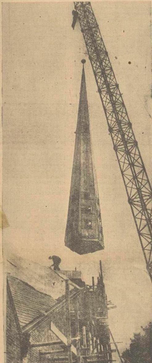
En la localidad de Oststebek, cerca de Hamburgo, se está construyendo una nueva iglesia. El campanario ha sido construido aparte, y en la foto vemos el momento en que es colocado por medio de una gigantesca grúa. Pesa seis toneladas y está fabricado a base de madera con recubrimiento de cobre. -- (FOTOFIEL)
