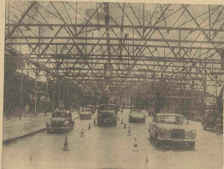
Va a construirse en Hamburgo-Elmsbuetel una gigantesca torre para la televisión, precisamente junto a la calle que vemos en la fotografía. Para proteger a los automovilistas y peatones de la caída de algún objeto se ha montado este techo a base de tubos metálicos y red protectora. --- (FOTOFIEL)
