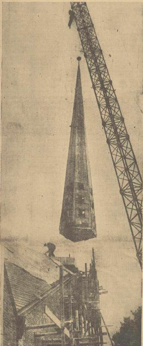
En la localidad de Oststeinbek, cerca de Hamburgo, se está construyendo una nueva iglesia. El campanario ha sido construido aparte, y en la foto vemos el momento en que es colocado por medio de una gigantesca grúa. Pesa seis toneladas y está fabricado a base de madera con recubrimiento de cobre. -- (FOTOFIEL)
