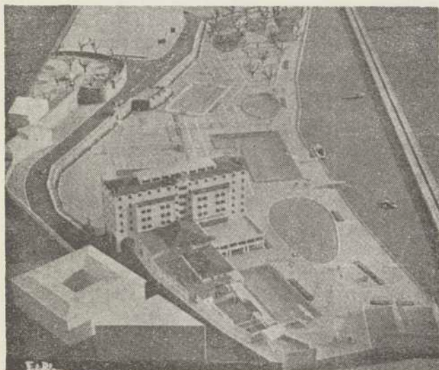
Complejo deportivo de ampliación de las instalaciones del Hotel Finisterre
