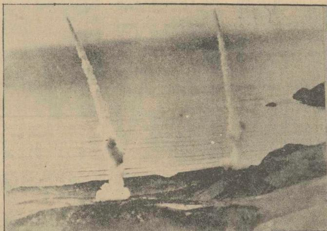
Las pruebas de lanzamiento de missiles no son ya ninguna novedad. Lo que, sin embargo, no es ya tan frecuente es que el lanzamiento no se realice de uno en uno. Esta fotografía está tomada en la base aérea de Vandenberg (California) y en ella podemos apreciar el lanzamiento simultáneo de dos missiles que, además, tienen la particularidad de poseer un segundo motor que, tras haber funcionado el primero, le da mayor alcance al gigantesco ingenio balístico. - (Foto Cifra Gráfica - UPI)
