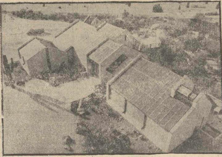
Una casa solar: tras los amplios paneles de los techos, una red de tubos de cobre garantiza una máxima eficacia en la captación de la energía del sol. — (Foto EFE-FIEL)
