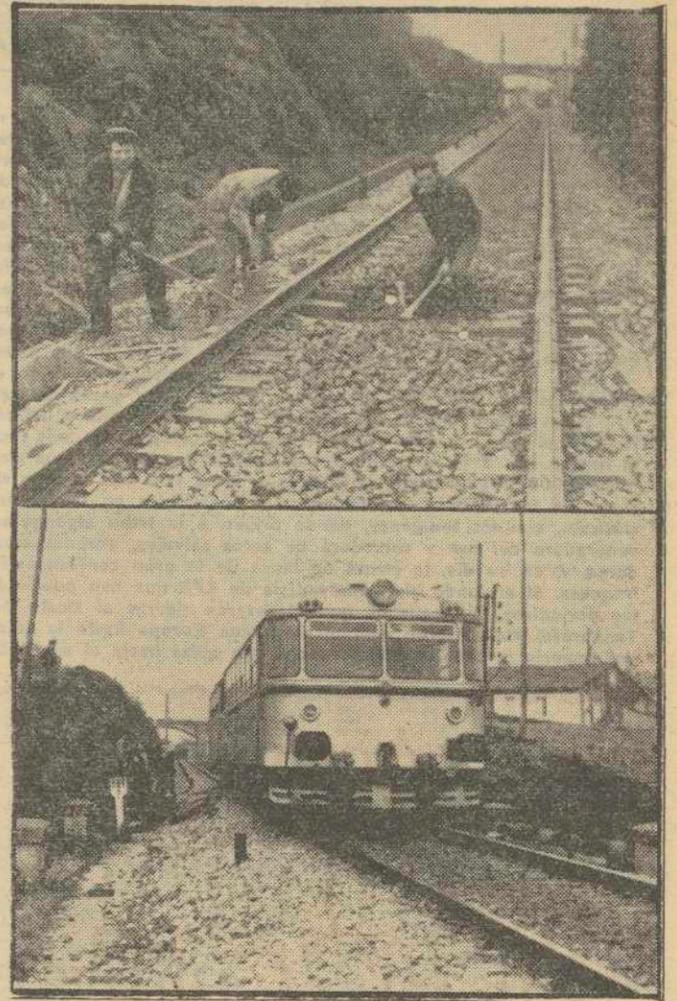
En la fotografía superior, los obreros de la RENFE proceden al arreglo de la vía en el lugar del descarrilamiento. Abajo, el Ferrobús circulando ya con normalidad por dicho punto. — (Fotos VEGA)
