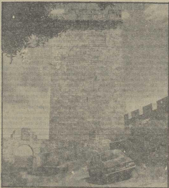
Torre del homenaje del Castillo de Monforte de Lemos, recientemente restaurado en su conjunto. — (Foto ARCADIO)
