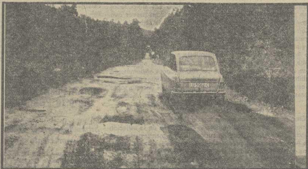
¡Y- que luego digan que exageramos, señor Ministros! Así, ni más ni menos estaba el viernes último la carretera de la Costa, en un lugar próximo a La Chalupa, entre Jove y Lago. Por tanto, sobran los comentarios tras echar una ojeada al grabado. — (Foto SERGIO)
