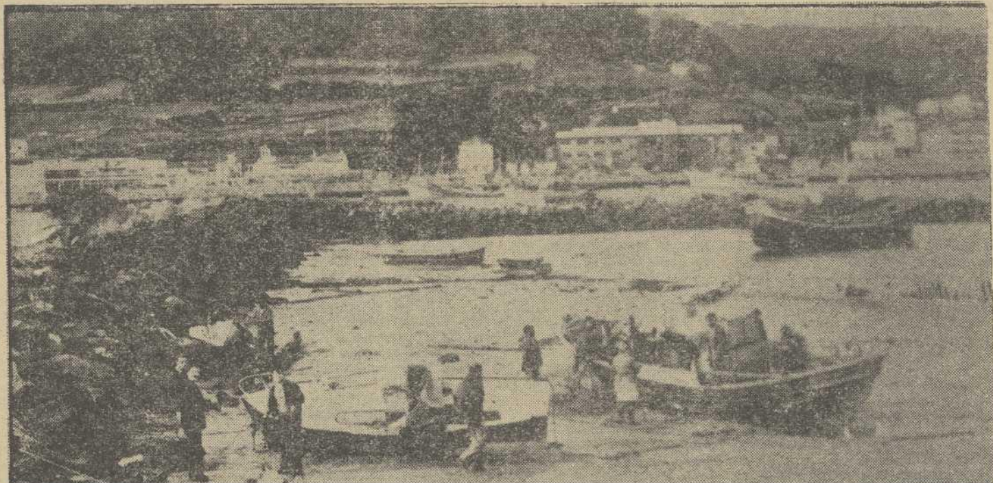
El viejo muelle vivariense hubo de servir ayer de refugio a muchas de las lanchas abrigadas en el muelle de Cillero, destruido por el empuje de las olas. Pero también hasta el fondo de la ría llegó la fuerza del temporal que causó destrozos en la Avenida Ramón Canosa, de unión Vivero Cillero, y arrastró hasta la vieja dársena botes de recreo y embarcaciones pequeñas, algunas de las cuales resultaron destruidas contra las piedras. Las embarcaciones hubieron de buscar refugio en Vivero y en la zona llamada de la Concha, al lado de la playa de Covas. — (Foto SERGIO)
