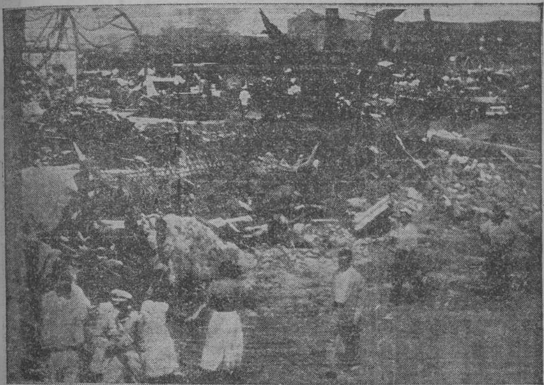
CALL— (Colombia). La mayor catástrofe del año fue la explosión de nueve camiones cargados de dinamita que dejó a la ciudad en el lamentable aspecto que registra la fotografía. Más de un millar de personas perecieron en el terrible accidente. (Foto Cifra Gráfica).
