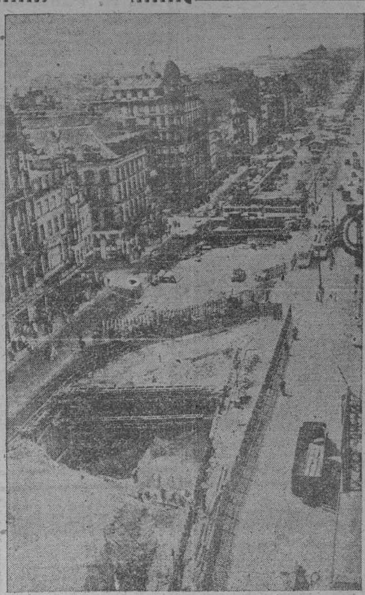
Las grandes ciudades tratan de resolver el problema de la circulación, creando pasos subterráneos para facilitar el tránsito en sus puntos críticos. En la fotografía se ve una de las obras que en este aspecto se realizan en Bruselas.
