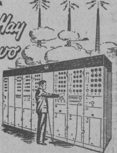
El sueño del portar de radio. El receptor de tipo «Diversity» de ondas cortas construido por la RCA, es el más perfecto en el campo de las comunicaciones. Reproduce tres copias diferentes de la misma transmisión en tres antenas diferentes y automáticamente selecciona la mejor. Esto misma técnica de la RCA, que ahora está dedicada a la causa de las Naciones Unidas, nos promete uno radio superior pero los días de paz.
