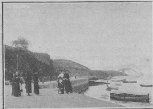
Fuerto de Ribadeo y cargadero de las minas de Villaodrid. (Fot. D. Tapia, af. o )
