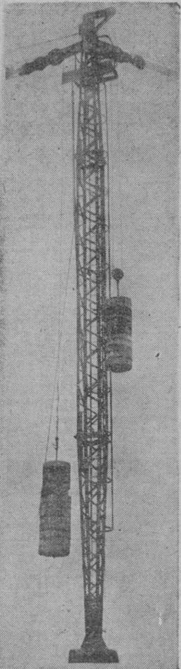
Grúa y transporte aéreo, todo en un sistema mecanizado. Este es el perfil de una de las torres metálicas del Biandin que se utiliza en la construcción del viaducto de La Rocha (Fotos Lavandera)
