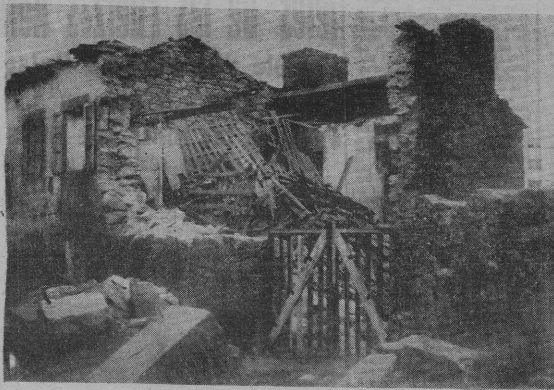
La casa número 7 de Campos de San José, derrumbada ayer
