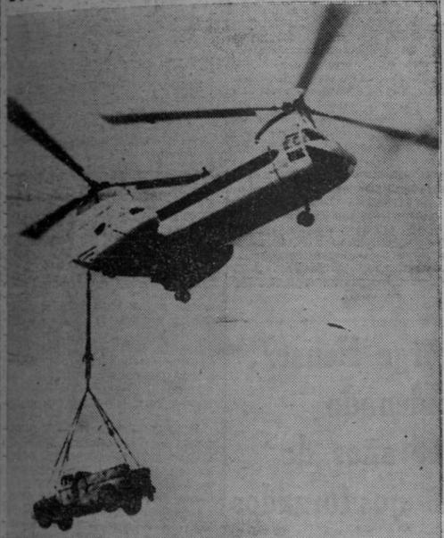
FILADELFA. ... La foto muestra las pruebas efectuadas por el nuevo helicóptero para transporte Boeing-Vertol 107. En el momento de la prueba está transportando un camión pesado. Para ello usa un gancho especial colocado en la parte posterior. (Foto Europa Press).
