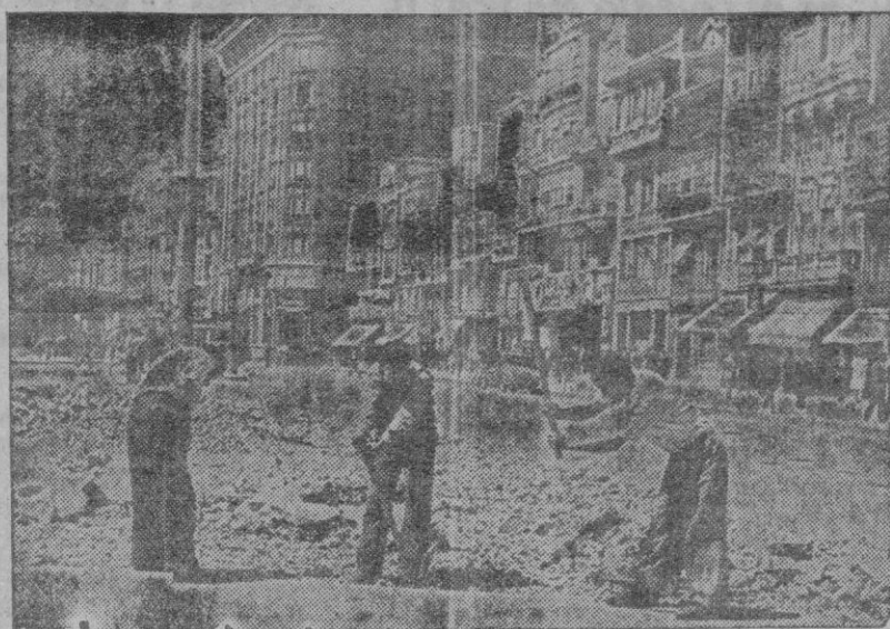
He aquí otra prueba más de las obras de embellecimiento que actualmente se realizan en La Coruña. La piqueta ha comenzado a actuar en la lágrima del Obelisco, que desaparecerá, para dar mayor amplitud a dicho céntrico lugar.
