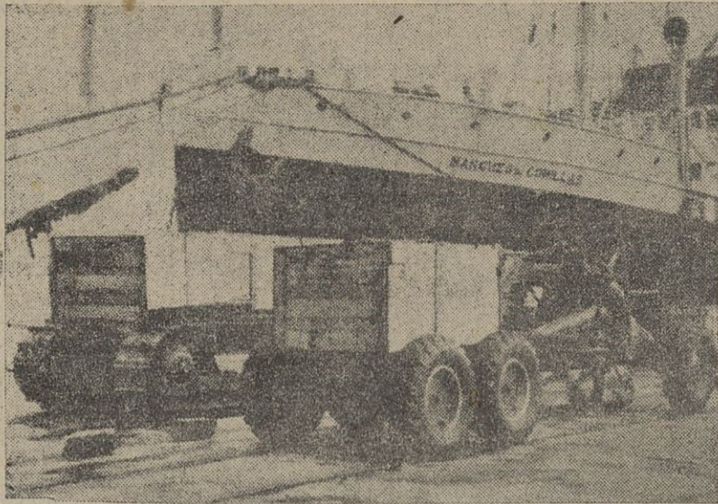
BILBAO.— Del "Marqués de Comillas", han sido desembarcados estos dos tractores, para la Guinea española, que pesan cada uno veinte toneladas y que hacen, además, de excavadoras y allanadoras (Foto CIFRA).
